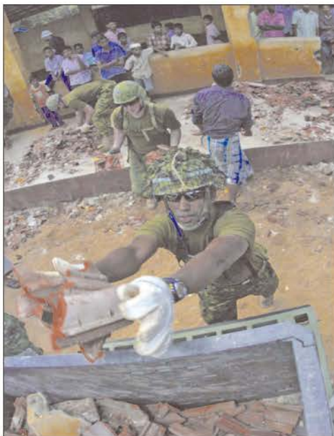
Аварийно-спасательные работы в районе землетрясения
